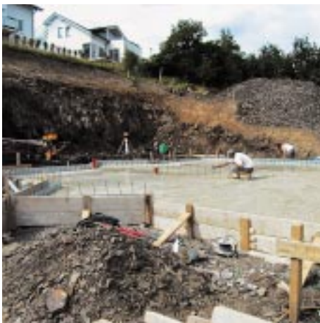
4. Tag: Bodenplatte
