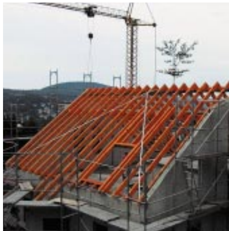
14. Tag: Dachkonstruktion und Richtfest
